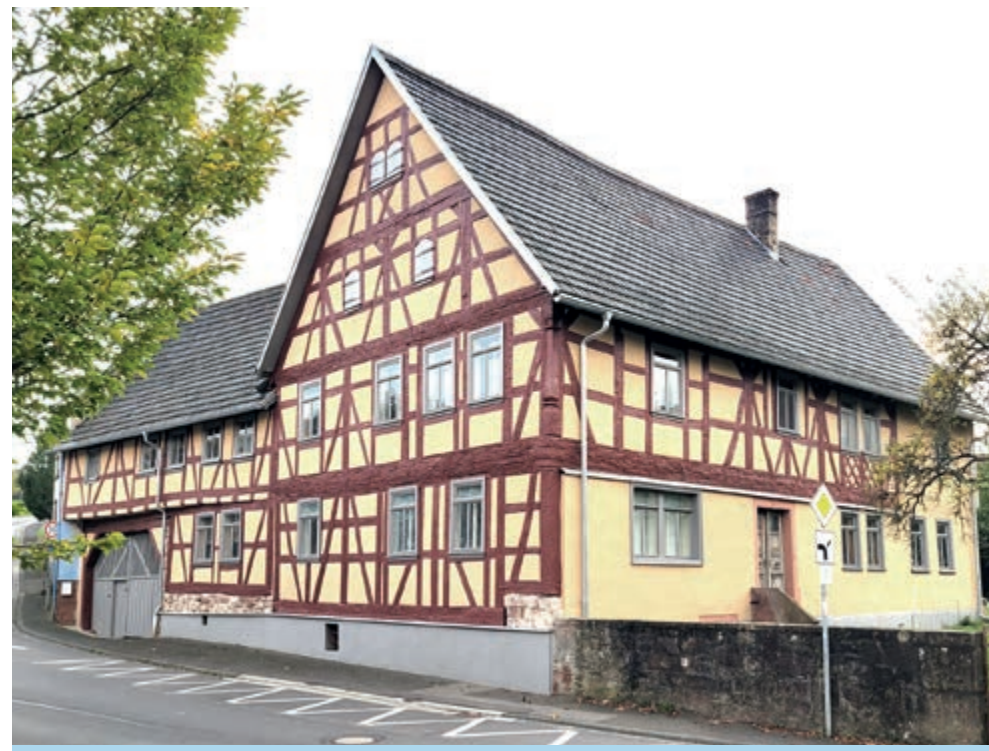
Die alte Zollstation mit freigelegtem Fachwerk
