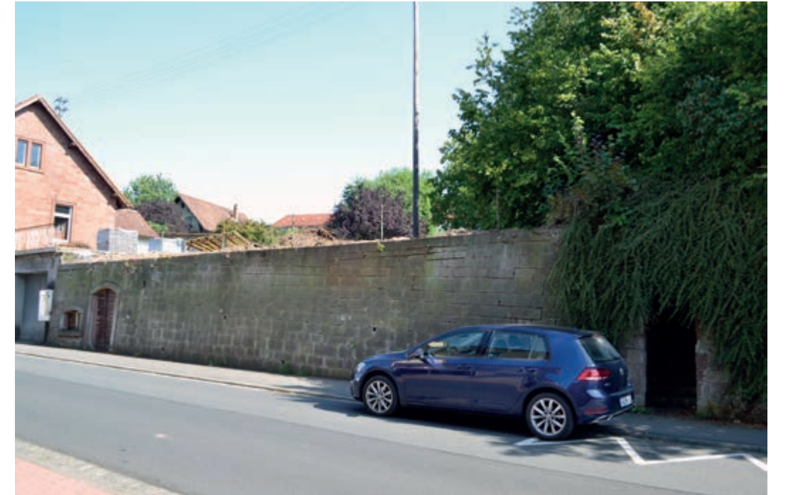
Foto der Mauer von 2019, heute mit Durchbruch
