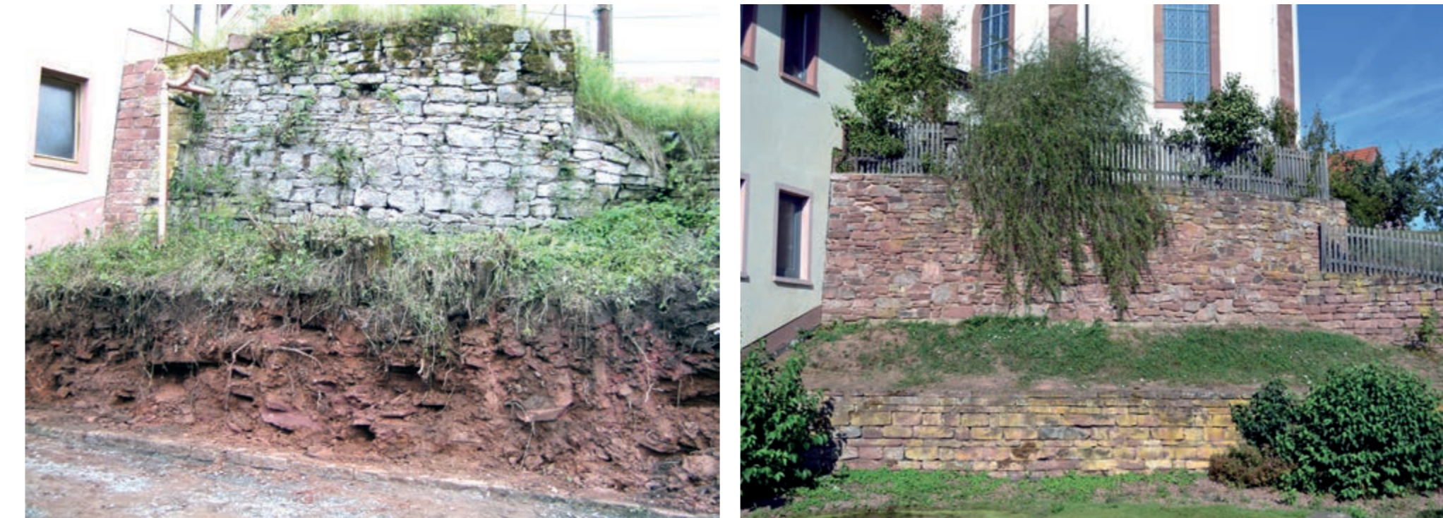
Östlich der Kirche: Einsturzgefährdete Überreste der Ummauerung um den Esselbacher Kirchberg und 2010 errichtete neue Mauer an alter Stelle in gleicher Form; hier dürfte das Hofgut zu verorten sein, das mutmaßlich der Wohnsitz der Ritterfamilie von Espelbach bis mindestens 1303 war.
