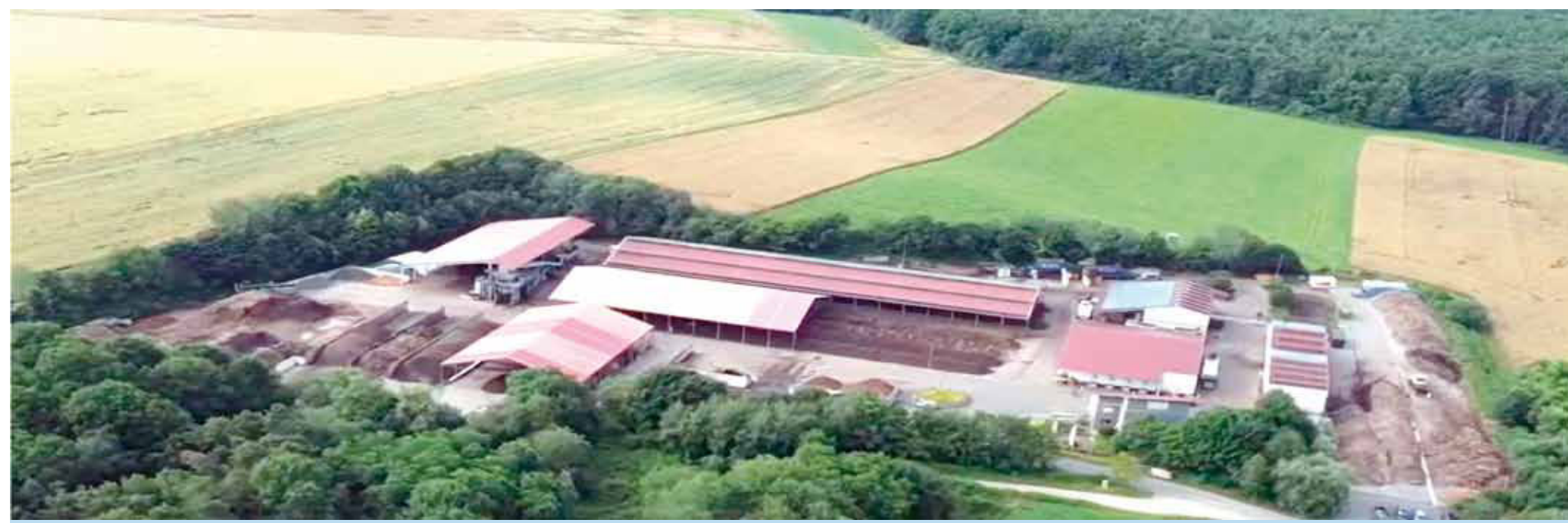
Die Anlage im Überblick
