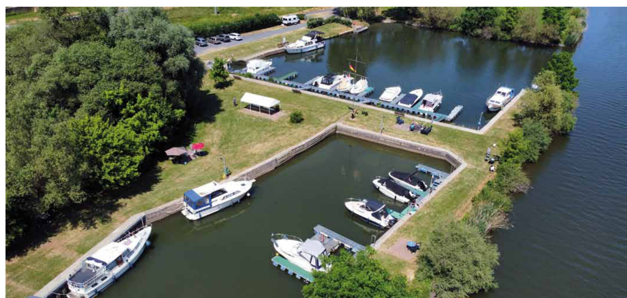
1971 gingen acht wassersportbegeisterte Männer ans Werk, um bei Mainkilometer 216,12 eine schwimmende Steganlage zu bauen. Es wurden Stromleitungen gelegt, ein Brunnen gebohrt, sanitäre Einrichtungen ausgebaut, ein Fahnenmast errichtet und das Hafengelände erweitert. Seither hat hier der Yachtclub Wernfeld seinen Sitz.
