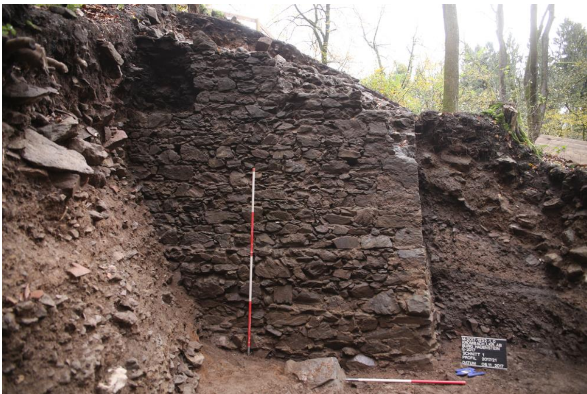
Blick auf die Ecke der Ringmauer von Norden
