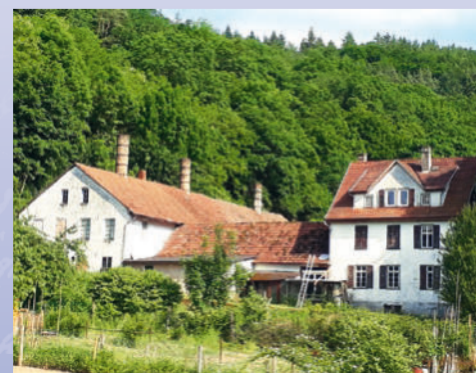
Anwesen der ehemaligen Bimssteinfabrik
