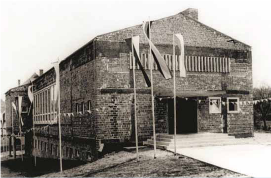
Die Halle ist fertig: Eröffnungstag 1964
