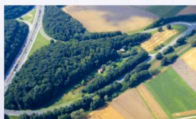
Das alte Wasserhaus ist heute durch die Autobahnabfahrt schwer erreichbar.
