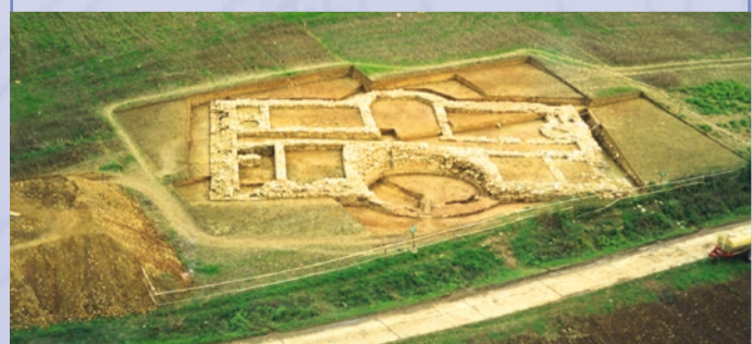
Die Fundamente bei der Freilegung
