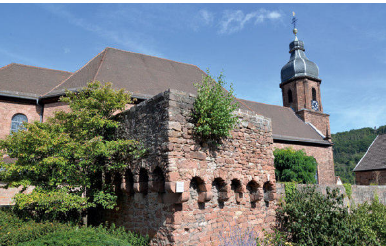
Ansicht der Wehrkirche St. Maria Magdalena in Klingenberg-Trennfurt
