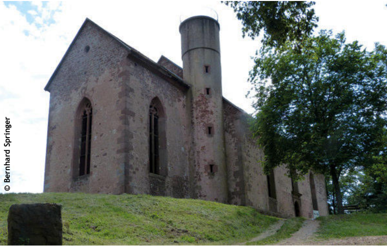
Ansicht der Gotthardsruine in Amorbach/Weilbach
