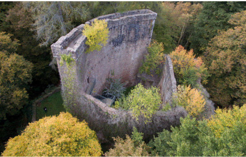
Luftaufnahme der Burg Stolzeneck in Neunkirchen
