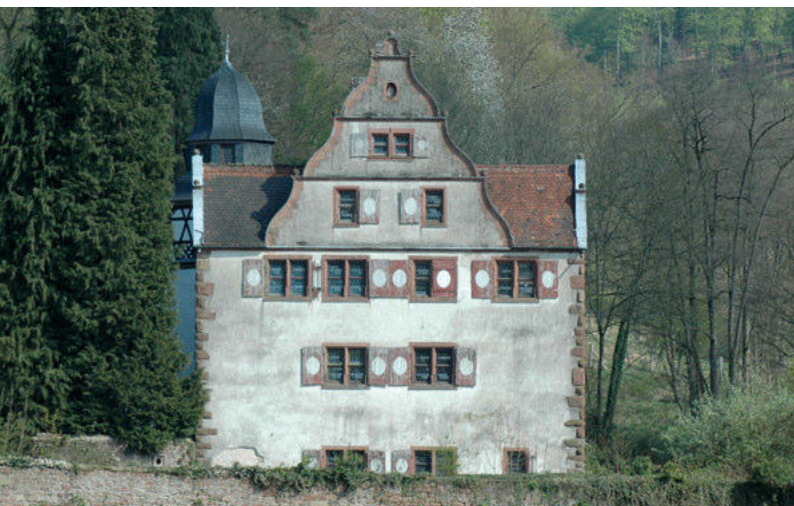
Ansicht des Wasserschlosses Oberaulenbach bei Eschau
