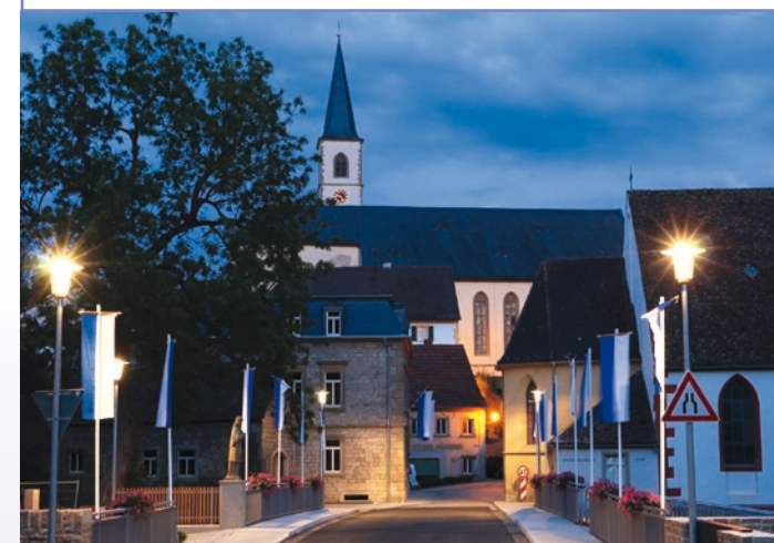
Nach der Sanierung 2020 wurde die Auber Gollachbrücke wieder für den Verkehr freigegeben.
