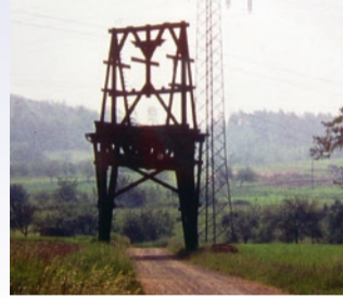
Stützpfiler der Materialbahn
