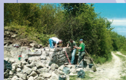
Ehrenamtliche aus Goßmannsdorf und Winterhausen haben 2011 bis 2013 die alten Gebäudereste gesichert.
