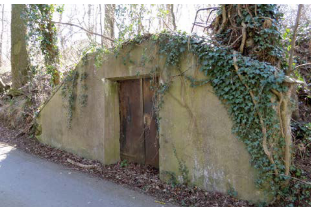
Zum Mühlenanwesen gehören mehrere Keller, die in den Hang gemauert wurden. Früher dienten sie wohl zur Lagerung von Bier der örtlichen Brauerei.
