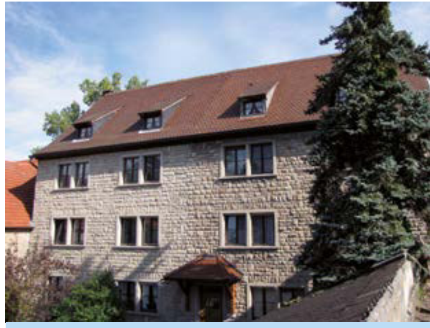
An der Schwarzach steht das Gebäude der Fuchsenmühle
