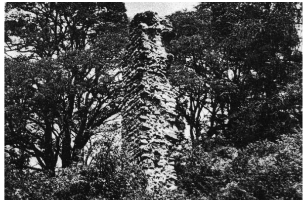
Abbildung 3: Am Fragment der Südwestecke der Ringmauer waren vor dessen Sanierung noch die einzelnen Geschosse des Palas erkennbar.
