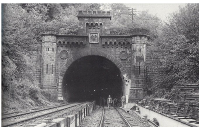
September 1962: Das Gleis ist tiefer gelegt.
