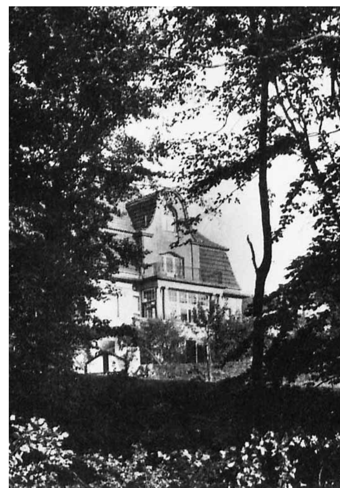
Villa des Fabrikdirektors (1909-1916) Dr. Georg Foucar, die später von dem Lokomotivführer Tann gekauft wurde und als „Tanns Villa“ bekannt ist.
