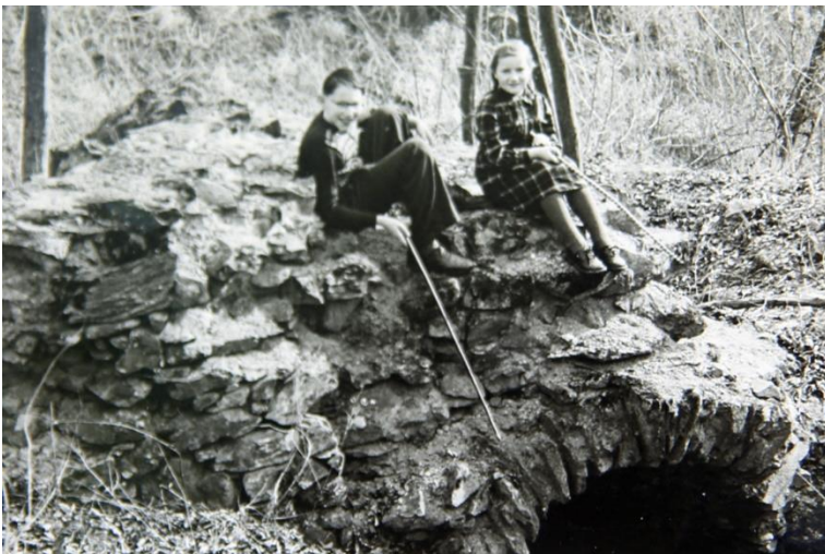
Abbildung 2: Aufnahme eines freigelegten Kellergewölbes als Sitzgelegenheit (Foto: Alois Scheller (+), Mömbris, 1956)
