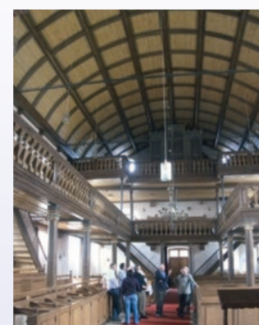
Das Kircheninnere mit dem beeindruckenden Tonnengewölbe und einem Detail der Empore
