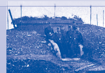
Auf dem Bocksberg (nicht direkt am Kulturweg) gab es im Zweiten Weltkrieg einen Beobachtungsbunker (Foto ca. 1942).
