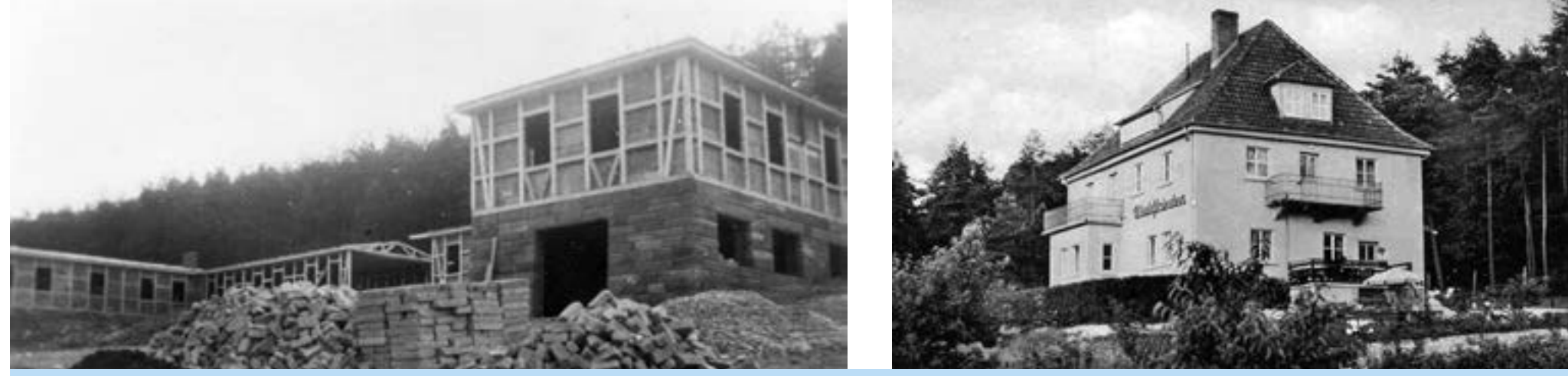
Oben: Bau des Segelfliegerheims um 1942; rechts das etwas oberhalb gelegene Haus, das 1949/50 von Josef Dengel erbaut wurde - ebenfalls ein Luftpionier. Das Gebäude diente später als Pension für Gäste aus dem „Ruhrpott“. Heute ist dort der Weinbaubetrieb Paul beheimatet.
