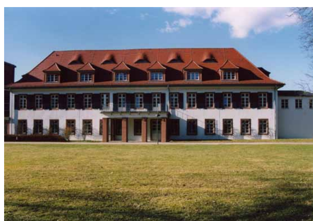
Das Wasserloser Schloss wurde 1767/68 als adeliger Landsitz errichtet.
