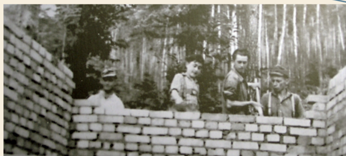
Alle halfen beim Bau der Stutzkapelle mit.
