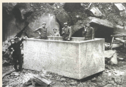
Arbeiter bei der Herstellung eines Troges.
