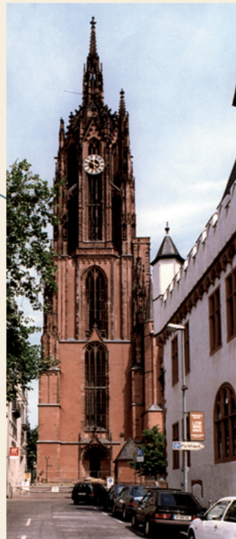
Auch der Frankfurter Dom wurde mit Buntsandstein vom bayerischen Untermain erbaut.
