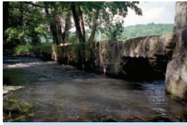
Bauwerk am Triftplatz zum Einholen der Hölzer
