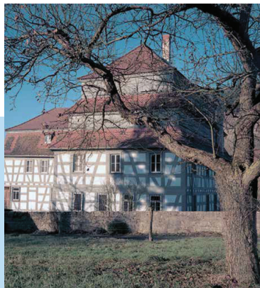
Am Rand von Hornburg am Main steht die Papiermühle mit ihrem pagodenartigen Walmdach, worin das Papier zum Trocknen aufgehängt wurde. Von 1806 bis 1975 wurde hier mit Wasserkraft Papier hergestellt. Heute ist die Papiermühle ein Museum. Da die technischen Geräte zur Papierherstellung erhalten sind, werden Vorführungen angeboten. Hinzu treten Sonderausstellungen zur kulturhistorischen Bedeutung des Papiers.
