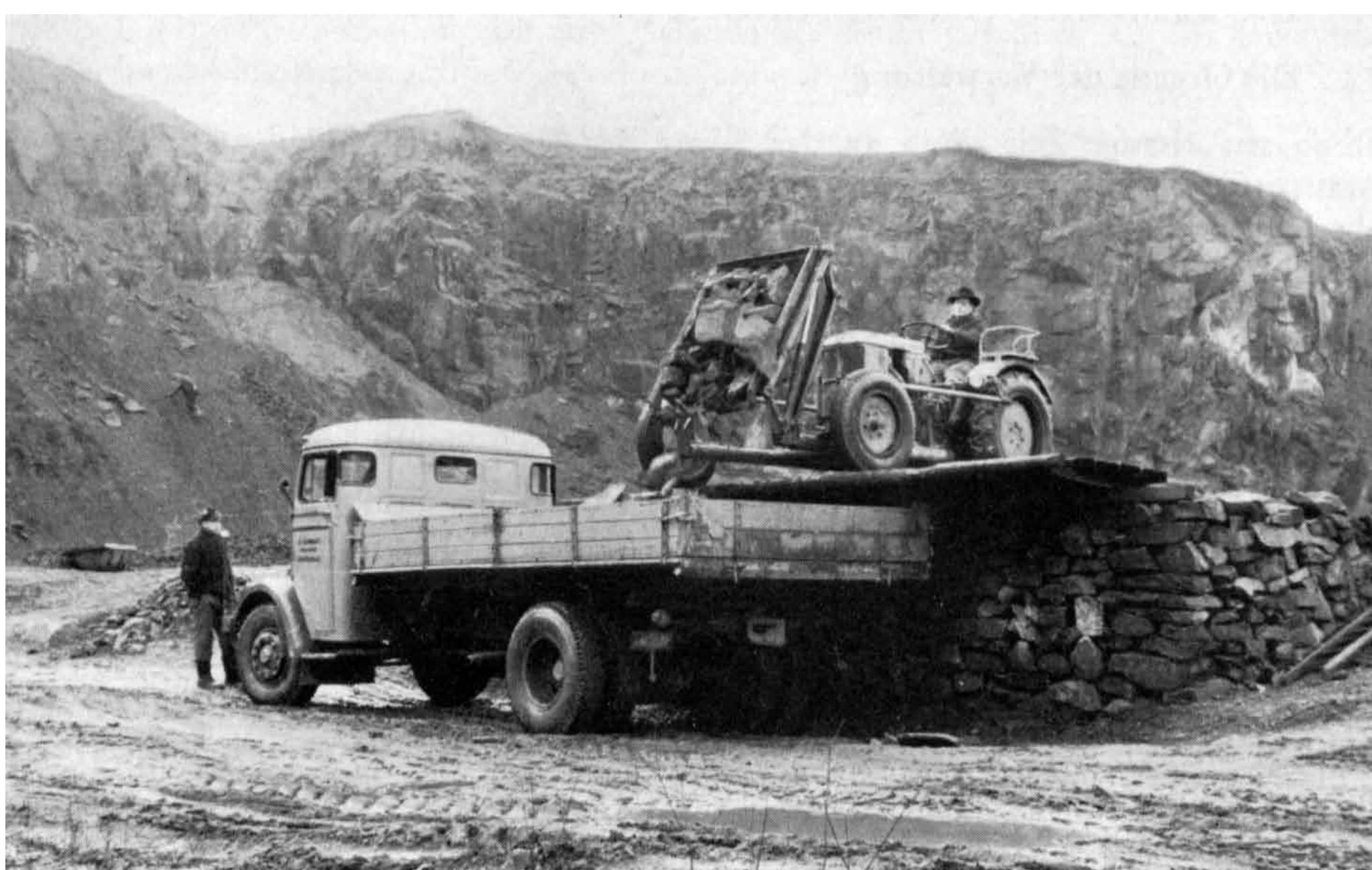
Der Wendelberg-Steinbruch wurde ab 1925 etwa 60 Jahre lang betrieben. Er lieferte als Baustein den sogenannten „Haibacher Blauen“, der aus Biotit-Gneis besteht. Das Foto zeigt die Verladung von Bruchsteinen vor dem Hintergrund der Steilwände.
