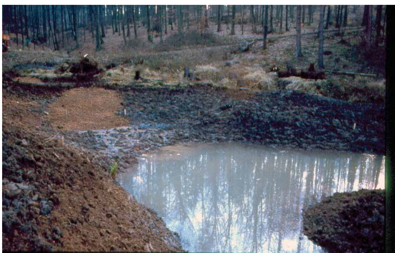
Bei der Anlage des Teichbodens wurde darauf geachtet, dass es Flach- und Tiefwasserbereiche gibt.
