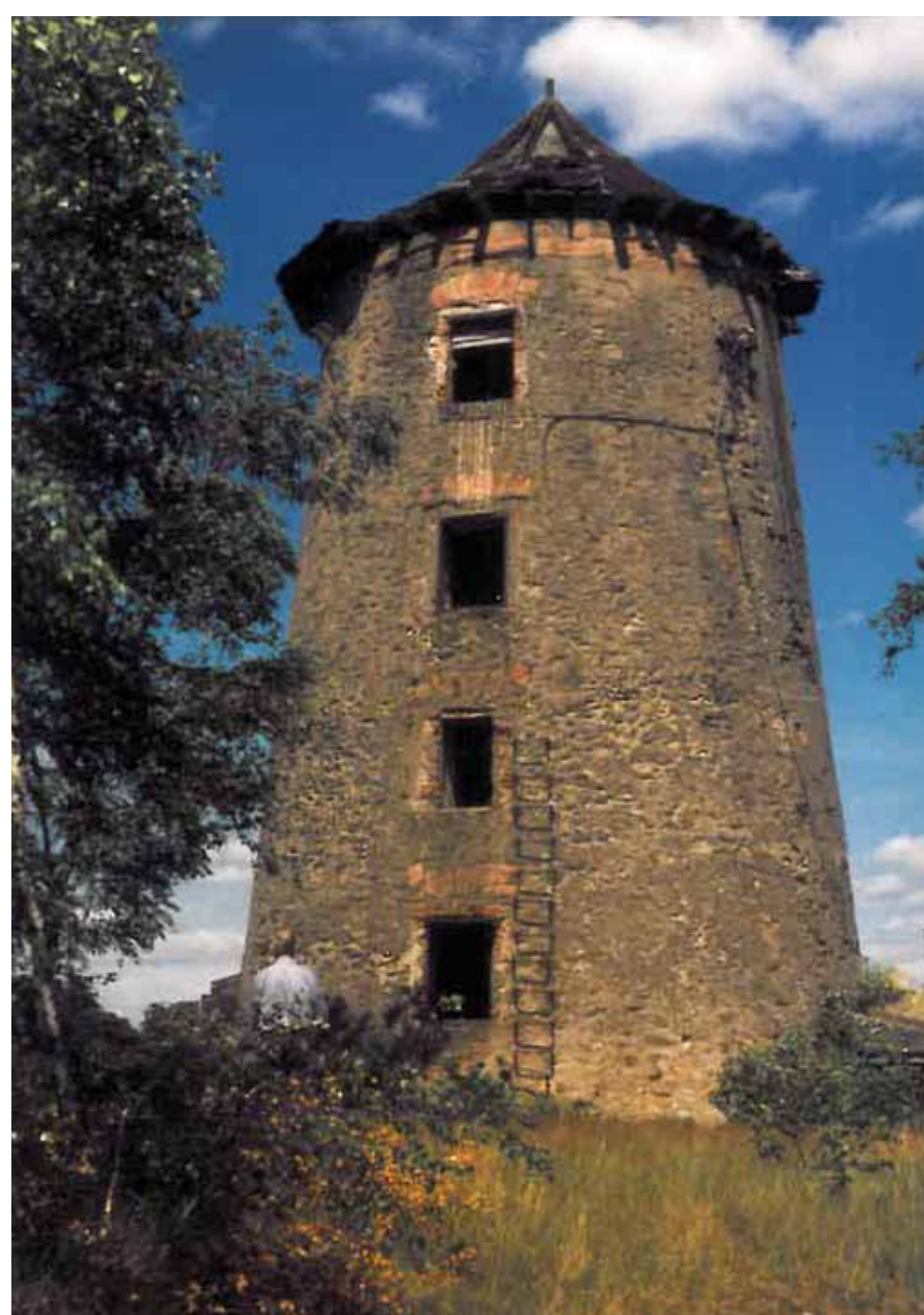
Der Turm kurz vor dem Abriss 1998
