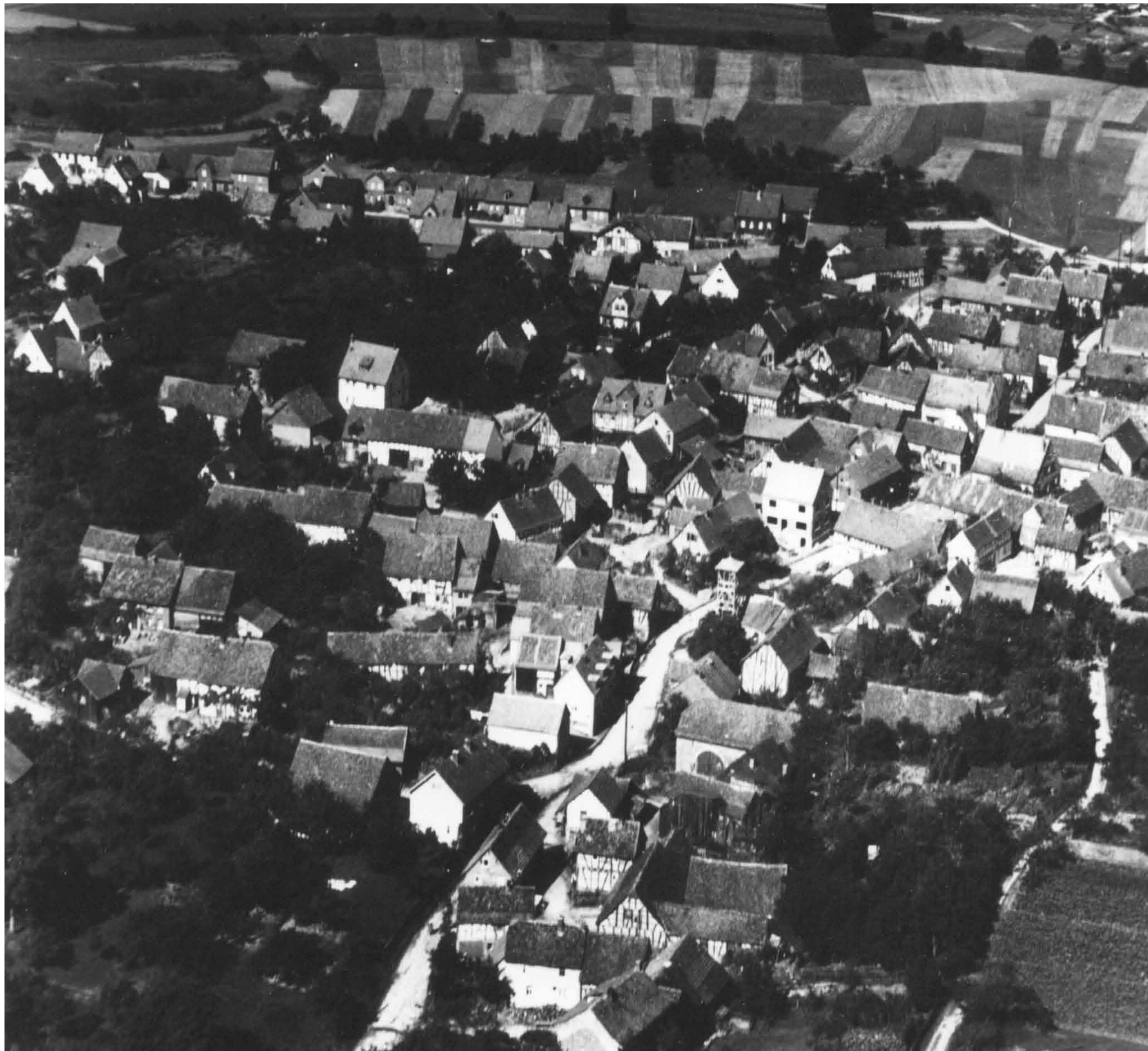
Luftaufnahme des Ortskerns von 1935.
