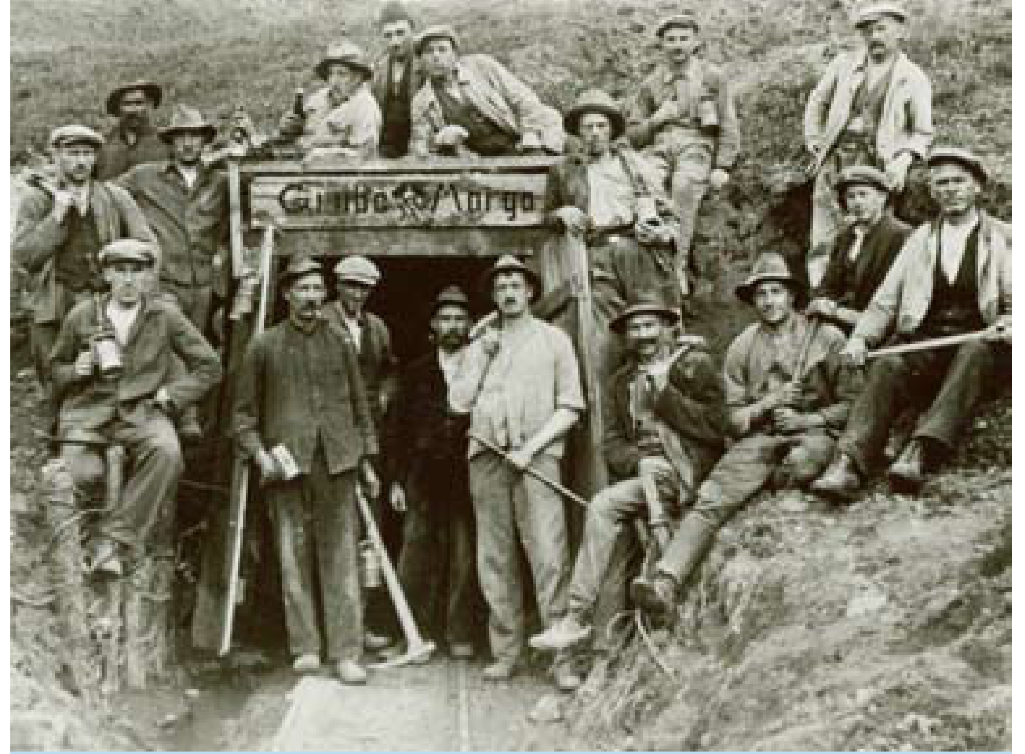
Das Stollenmundloch der Grube Marga um 1934 mit 18 Bergleuten. Wie an den brennenden Karbidlampen zu sehen ist, gab es damals kein elektrisches Licht im Bergwerk. Statt Schutz-helmen trug man Hüte und das Werkzeug bestand aus Keilhau, Fäustel und Meißeln.
