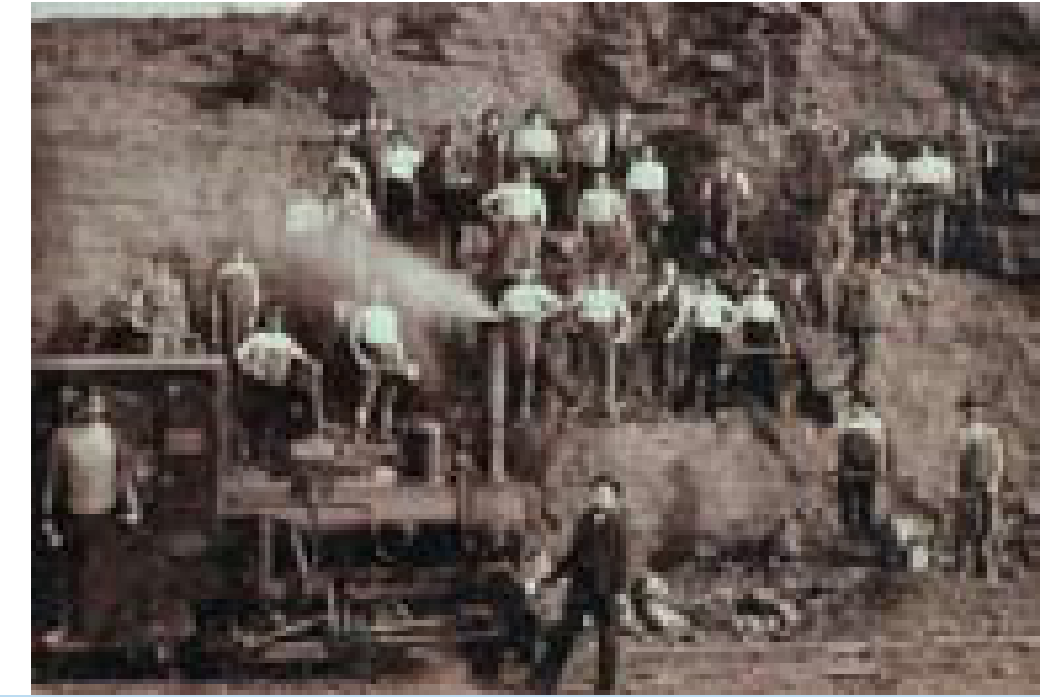
Links: Bild aus den Anfängen des Steinbruches bei Eichenberg: Der Dolomit wurde mit den Brechstangen gelockert, in eine handliche Größe zerkleinert und zunächst auf von Pferden gezogenen Loren zur Winkelstation transportiert (um 1900). Rechts die Situation einige Jahre später: Der Dolomit wird auf mehreren Terrassen abgebaut und mit der Kleinbahn zur Winkelstation abtransportiert. Von hier gab es eine Seilbahntrasse ab 1926.
