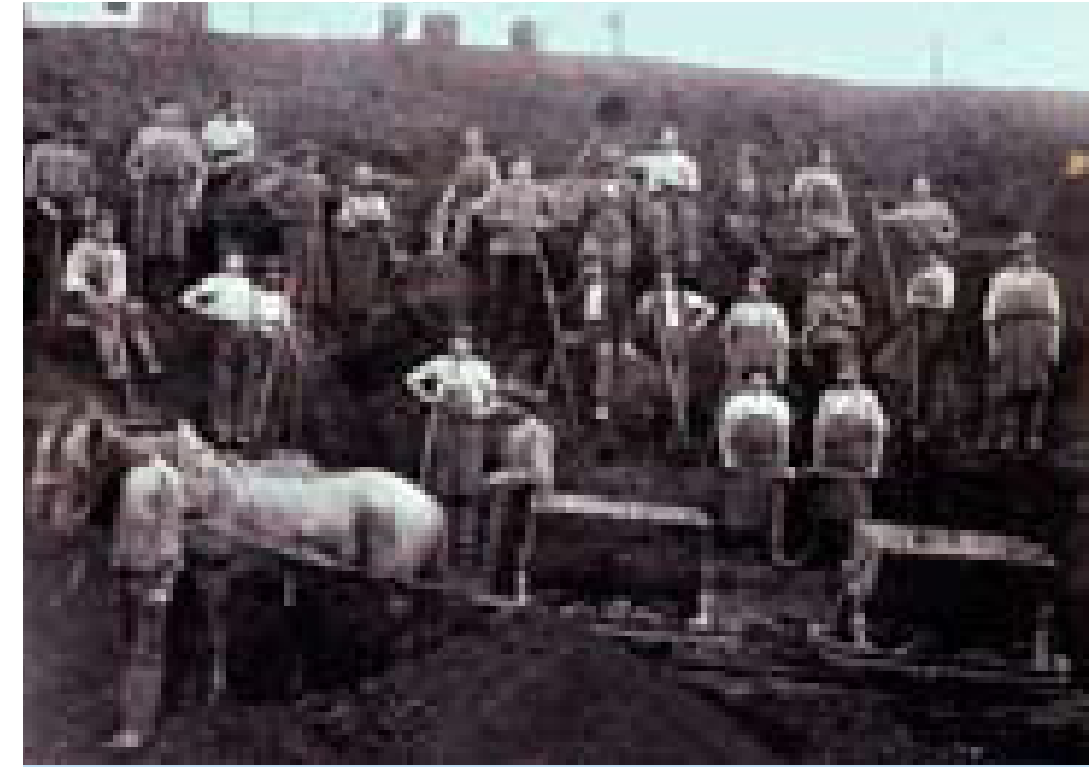
Links: Bild aus den Anfängen des Steinbruches bei Eichenberg: Der Dolomit wurde mit den Brechstangen gelockert, in eine handliche Größe zerkleinert und zunächst auf von Pferden gezogenen Loren zur Winkelstation transportiert (um 1900). Rechts die Situation einige Jahre später: Der Dolomit wird auf mehreren Terrassen abgebaut und mit der Kleinbahn zur Winkelstation abtransportiert. Von hier gab es eine Seilbahntrasse ab 1926.
