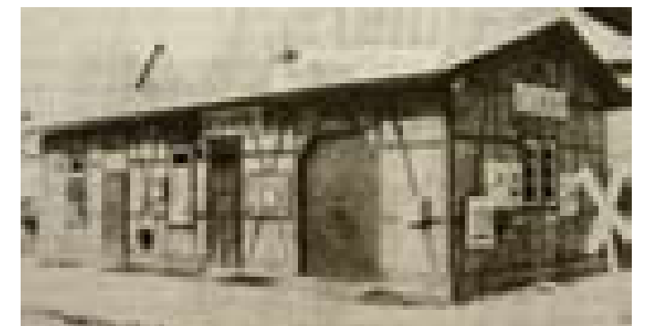
Die historische Bahnhofstation Blankenbach.
