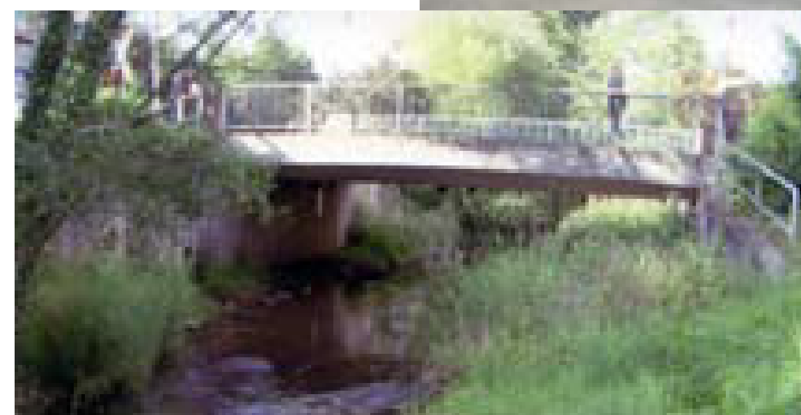
Seit 1991 überspannt die moderne Stahlbetonbrücke die Kahl.
