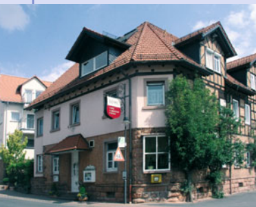
Ein weiterer Startpunkt des Kulturweges befindet sich am Blankenbacher Bahnhof neben dem Hotel Brennhaus Behl (ehemaliger Gasthof »Zur Linde«).
