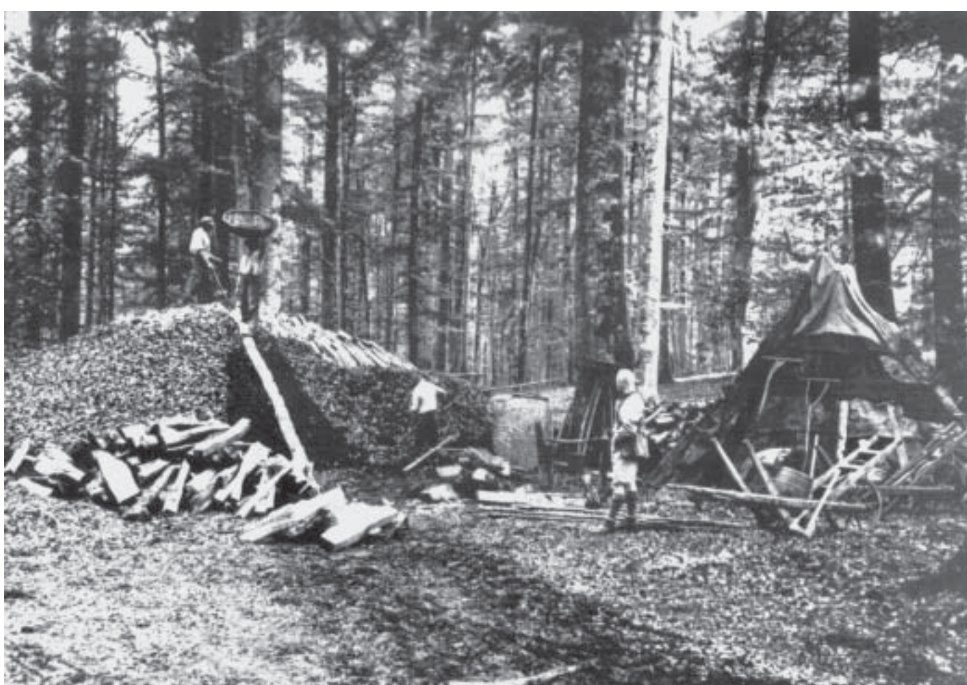
Foto eines Kohlemeilers um 1930. Rechts ist das Zelt der Köhler zu erkennen. Der Meiler hat bereits seinen endgültigen Umfang erreicht und wird nun mit Laub abgedeckt, das in geflochtenen Kippen herangeschafft wird. Im Vordergrund links ist noch Spatholz zu erkennen, rechts vor dem Zelt Arbeitsgeräte wie Laubrechen und Karren.
