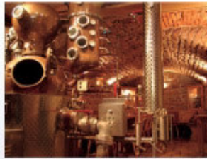
Das Kellergewölbe lädt ein zum Kosten der hausgemachten Brennereierzeugnisse.
