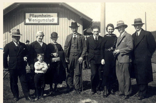
Wenige Meter von hier lag der Bahnhof Pflaumheim-Wenigumstadt der Bahnlinie Aschaffenburg-Höchst (1912-1974).
