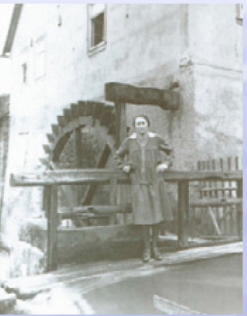
Mühlgraben und Mühlrad der ehemaligen Pfarrmühle in Schöllkrippen
