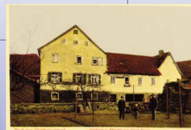
Im Keller des Hausteiles auf der rechten Seite mit der Giebelseite zur Straße befand sich der Brunnen.
