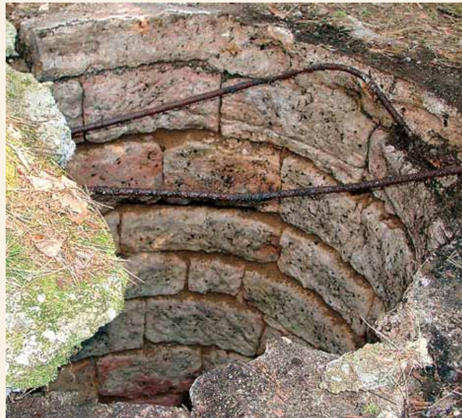
Brunnenschacht vor der Sicherung
