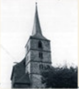
So sah die Wolfgangskirche vor der Sanierung aus.
