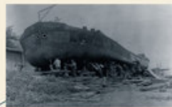
Der Rumpf eines Mainschiffs in Bau.
