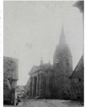
Das älteste Foto der Kirche mit dem klassizistischen Vorbau von Herigoyen mit Treppe.
