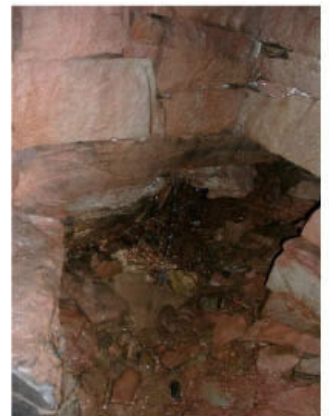
Neben dem Kirchhof befindet sich eine, heute nicht mehr sichtbare, tiefreichende Brunnenstube, in der eine Quelle gefasst und über Sandsteinplatten nach draußen geführt wird.
