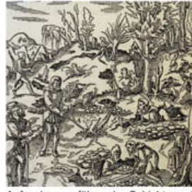
Aufsuchen erzführender Schichten mit Wünschelrute (A) und Schürfgraben (B) aus den 12 Büchern über Bergbau und Hüttenwesen von Georg Agricola (1556).
