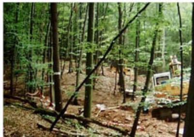
Der Bagger grub und fand einen viereckigen Schacht.
