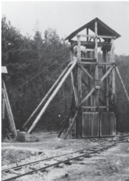
Der Förderturm des Marienschachts mit dem Lorengleis.
