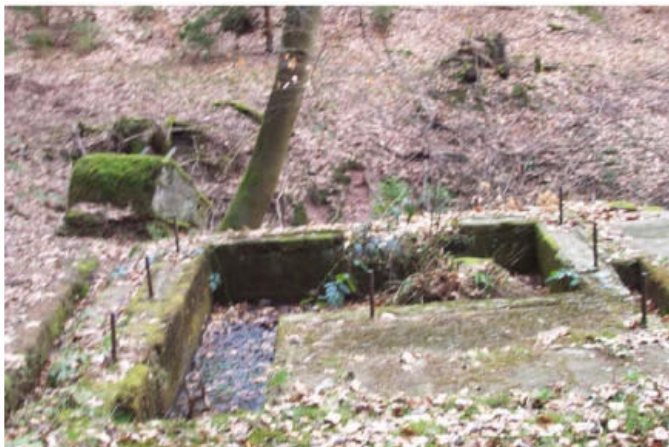
Die Reste der Anlagegebäude des Marienschachtes sind fast von der Natur zurückerobert worden. Das Schachtloch ist verstürzt, die Fundamente verrutscht. Bitte nähern Sie sich nicht den Einsturztrichtern. Pingen (Senken, die aufgrund eingestürzter Stollen entstanden sind) im Wald hinter dem Marienschacht zeigen die Bergbautätigkeit an, die sich über mehrere Kilometer Stollenverlauf erstreckte.
