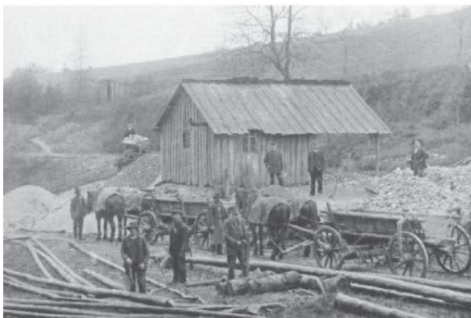
In der Nähe des Marienschachtes endete ein Lorengleis. Hier war (um 1914) die Putz- und Verladestelle, wo die Spatbrocken gereinigt und auf Pferdefuhrwerke verladen wurden. Die Abfuhrstrecke ins Tal wurde wegen der Spatkiesel „Weisser Weg“ genannt.
