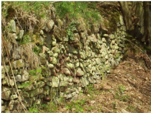
Die Trockenmauern im Langer Grund sind noch sehr gut erhalten. Sie erlaubten die ackerbauliche Nutzung auf künstlich geschaffenen ebenen Terrassen zwischen den bis zu 1,5 m hohen Abstufungen.
