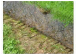
Die rolierte Befestigung aus den 1930er Jahren ist am Elsavabach noch zu erkennen.
