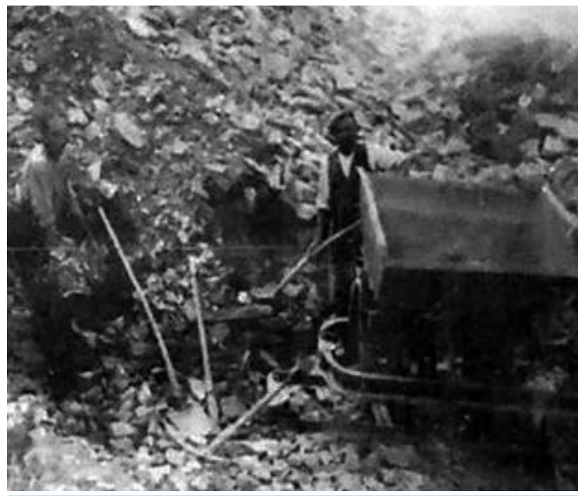
Eine Lore wird mit Steinabraum beladen (Goßmannsdorf).
