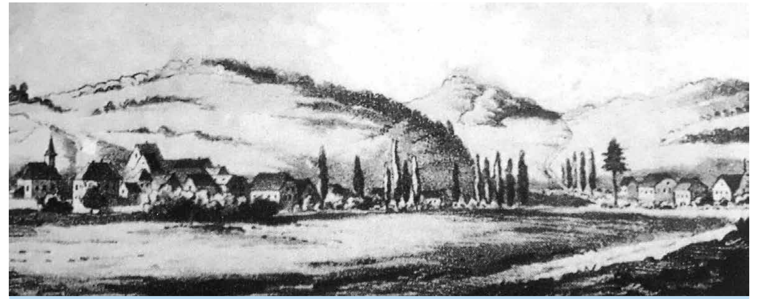
Roßbrunn um 1820 mit der früheren Kirche, Pfarrhaus, Zehntscheune, Kirchberg, alte Poststraße und Posthäuser
