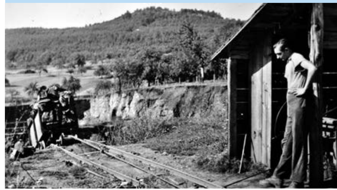
Links oben: Der Kalksteinbruch im August 1939; rechts oben und unten: Der Kalksteinbruch mit Rohsteintransport in Kipploren auf Schienen um 1950.
