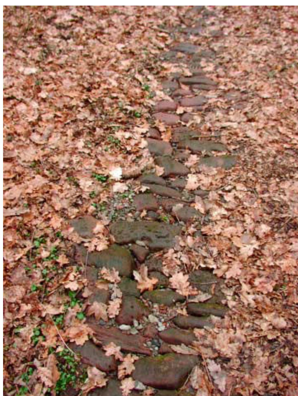
Auf Teilstrecken ist die Pflasterung der „Klapper“ noch sichtbar. Man versuchte auf diese Weise, den Rädern einen festen Untergrund zu geben und die Erosion zu stoppen.
