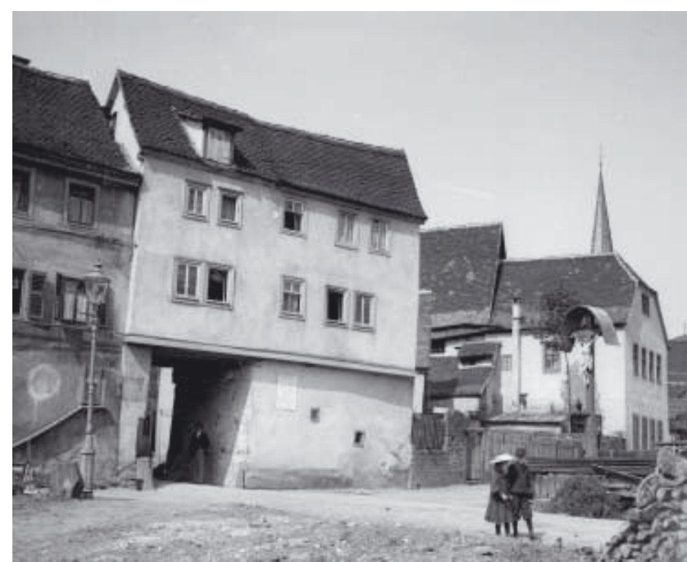
Hier am Fischertor, das im 15. Jahrhundert erbaut wurde, beginnt der Kulturweg.
